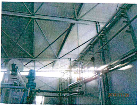
Tettoia autoportante e pareti di protezione laterale
