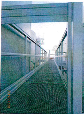
passatoia di collegamento silos esterni - Soppalco fuori perimetro e parte di impianto sospeso
